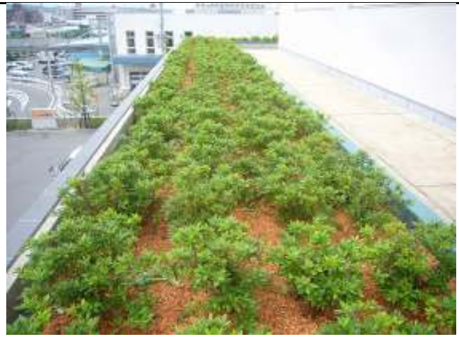
十条換気所屋上緑化
