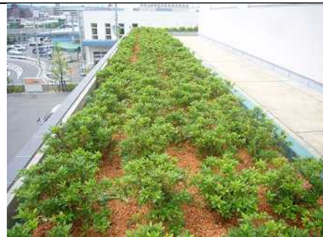
阪神高速十条換気所屋上緑化
