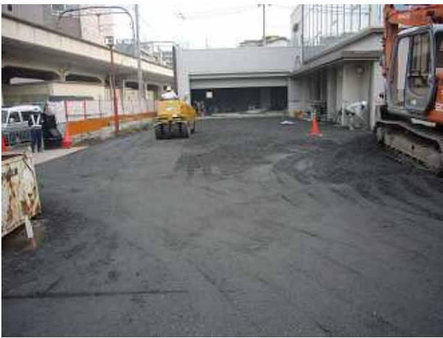
国交省第二維持出張所庁舎 透水舗装路盤材
