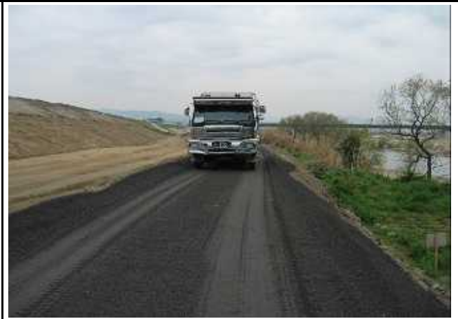
木津川堤防強化工事
