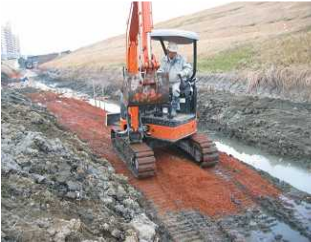
久御山地区整備工事
