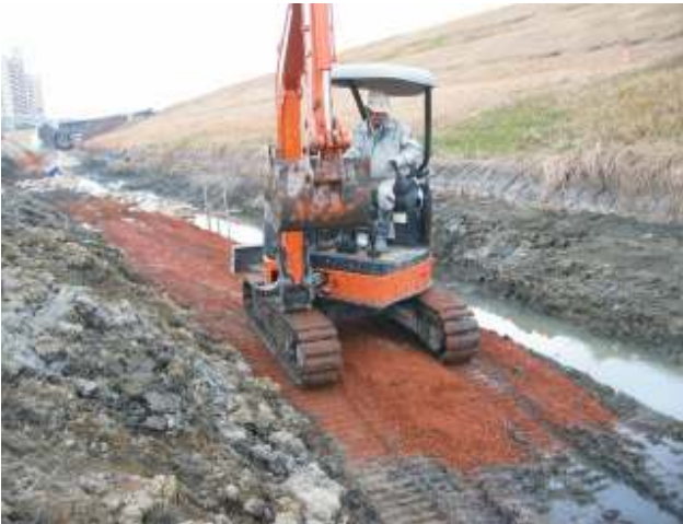
久御山地区整備工事
