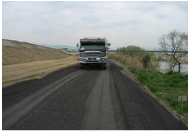
木津川堤防強化工事
