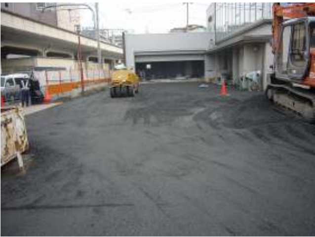
国交省第二維持出張所庁舎 透水舗装路盤材
